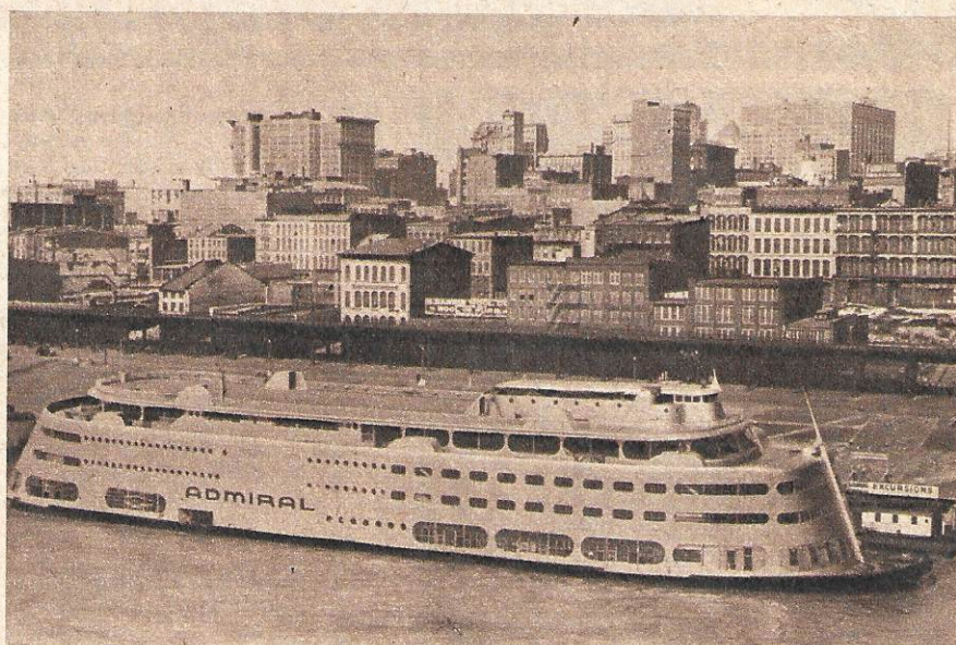
Nur über der Wasserlinie unterscheidet sich dieses Stromlinien-Ausflugsschiff, das hier in St. Louis vor Anker liegt, von den alten Mississippi-dampfern. Wegen der zahlreichen Untiefen sind auch die modernsten Schiffe, die flussaufwärts von New Orleans verkehren, plattenartig gebaut.
