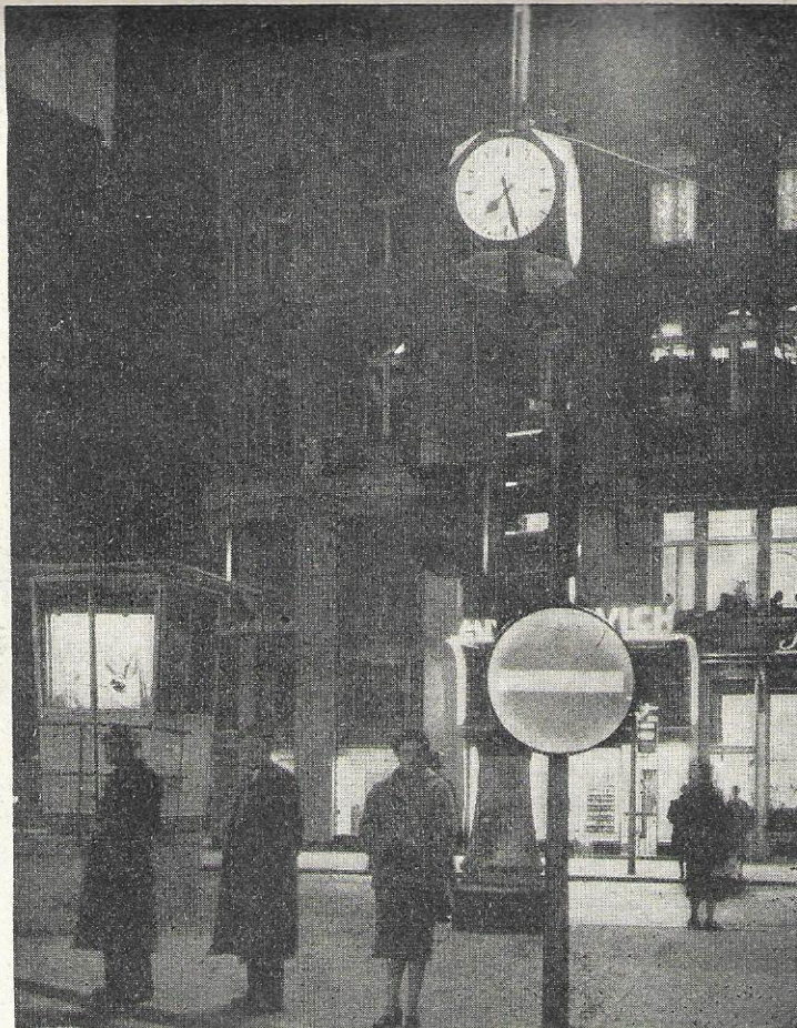
Auch bei Nacht nicht zu übersehen sind die von innen beleuchteten Verkehrszeichen aus farbigem Glas, die kürzlich in der Wiener Innenstadt aufgestellt wurden.
