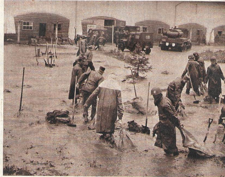
Amerikanische Soldaten wurden aufgeboten, um Sandsäcke zu füllen, mit denen Behelfsdämme errichtet wurden.
