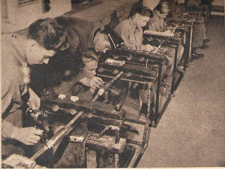
Kabelmontage ist eines der wichtigsten Fächer. Unter der geduldigen Anleitung des Telegraphenwerkmeisters Balsam werden zunächst die Verbindungen an Telefonkabeln hergestellt.
