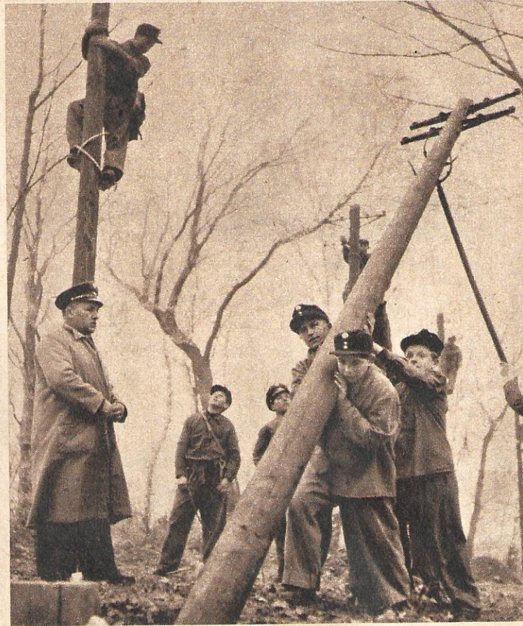
Kraft und Geschicklichkeit erfordern das Aufrichten und Erklettern der Telephonmaste. Der Lehrling muß also auch die nötige körperliche Robustheit mitbringen.
