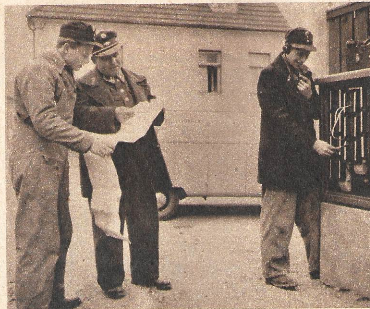
Vom zweiten Jahr an haben die Lehrlinge Außendienst und arbeiten sich langsam zur Selbständigkeit hinauf. Hier wird unter Anleitung eines Werkmeisters eine selbstgelegte Telephonleitung überprüft.
