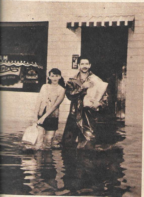
SEIT TIEF UNTER WASSER standen viele Straßen von Chicago, als es kürzlich zwei Tage ununterbrochen regnete und die größte Niederschlagsmenge, die in der Stadt jemals gemessen wurde.
