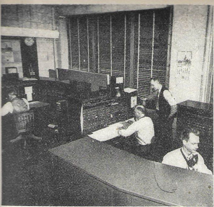
Signale und Weichen werden von Zentralstellwerken bedient. In welchem Streckenabschnitt sich die einzelnen Garnituren befinden, ist auf einer Kontrolltafel ersichtlich. Einzelne Züge weisen Radar-Anlagen auf, die den Lokomotivführer warnen, wenn sein Zug einer auf demselben Gleis fahrenden Garnitur zu nahe gekommen ist.
