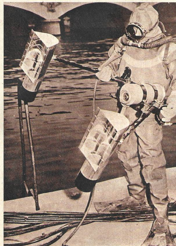
Für die Taucher von Bergungsgesellschaft und Wissenschaftler bestimmt ist die Unterwasserfernskamera mit gekoppelter Beleuchtungsanlage, die auf Pariser Seefahrt-Ausstellung am Seineufer gezeigt wurde.
