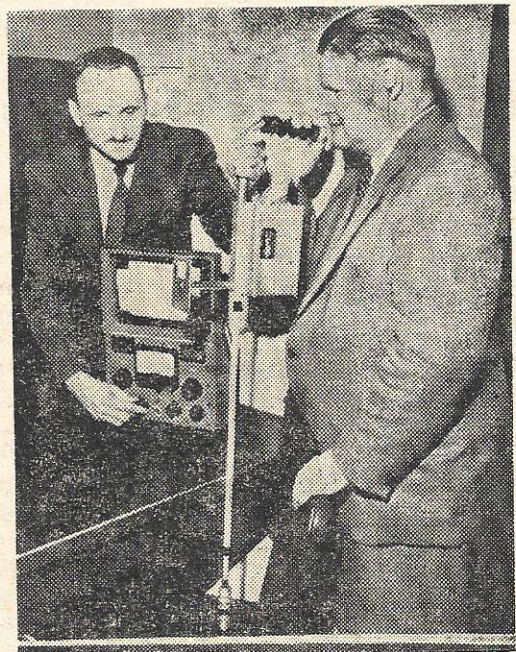
Einen sehenden Spazierstock für Blinde konstruierte der seit seinem zwölften Lebensjahr erblindete Amerikaner Augie McCollum. Das zwei Kilogramm schwere, an einem Spazierstock befestigte Gerät sendet Radiowellen aus, deren Echo an festen Gegenständen wieder empfangen wird. Die durch den Zeitunterschied festgestellte Entfernung äußert sich durch verschieden hohe Summtöne in einem Hörer, den der Blinde im Ohr trägt. (AND)
