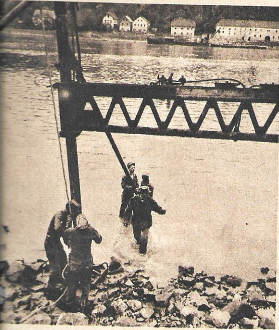
EINE NEUE ANLEGESTELLE für die Ascher Rollfähre an Stelle der vom Hochwasser zerstörten bauen USFA-Pioniere, die auch das gesunkene Mittelstück der Fähre heben.
