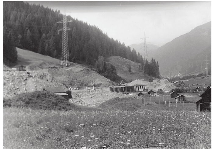
Beginn der Bauarbeiten an der Abfahrt Pettneu
