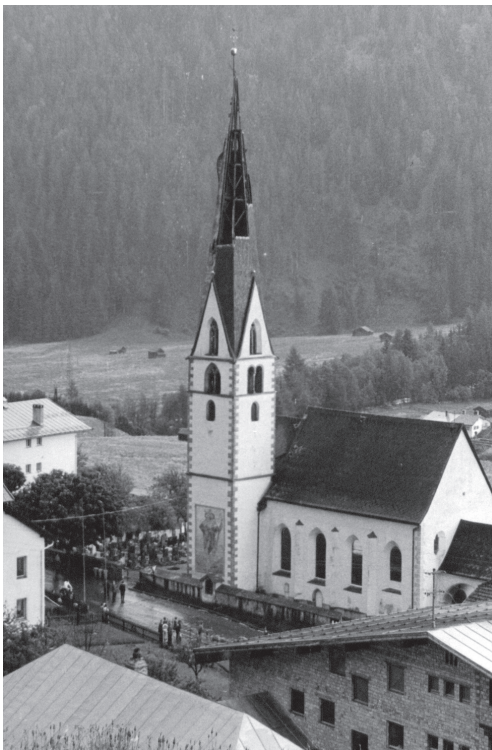
Vom Blitz zerstörter Kirchturm 1971
