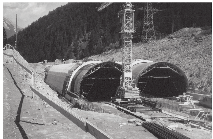
Beginn der Bauarbeiten an der Abfahrt Strohsack
