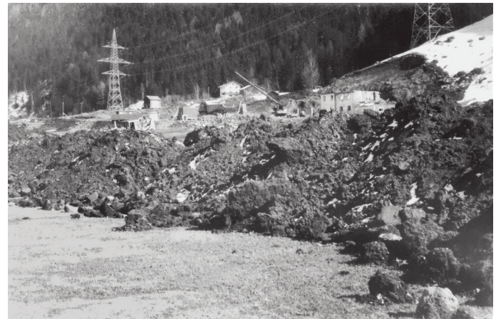
Der Hof im hinteren Strohsack, den die Familie Lampacher bewohnte, musste abgerissen werden.
