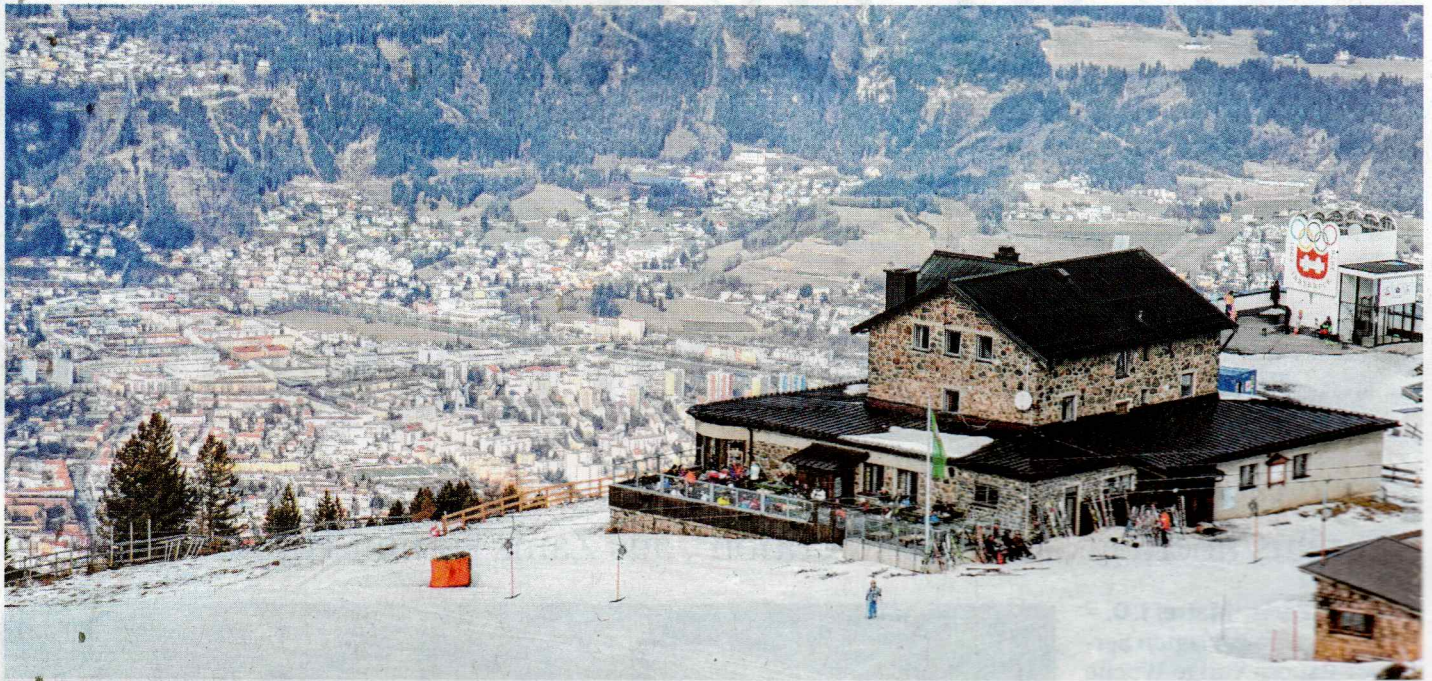
Die vertraglich vereinbarten 250.000 Euro für einen Ausbau der Schutzhaus-Terrasse dürften rechtlich wohl auf einen neuen Käufer übergehen. Foto: Böhm
