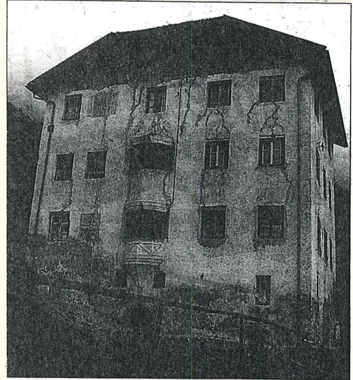
Der Turm in Ötz - bereits eine Million wurde investiert, noch fließen keine Mittel aus Wien. OR 03, 19. 1995
