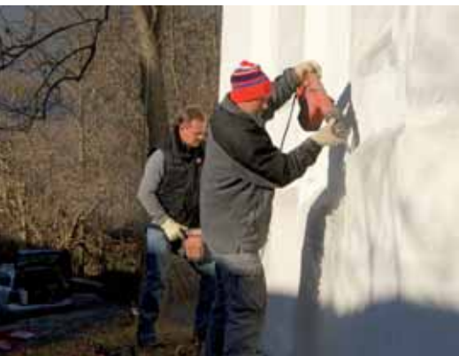
Beginn Sanierung Rochuskapelle 2011
