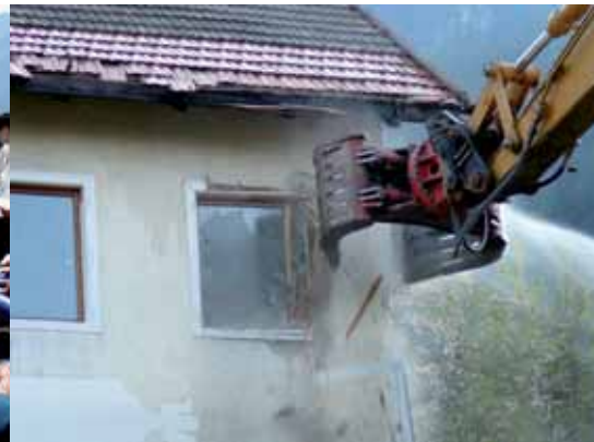
Abriss alte Schule / Gemeindeamt 2008
