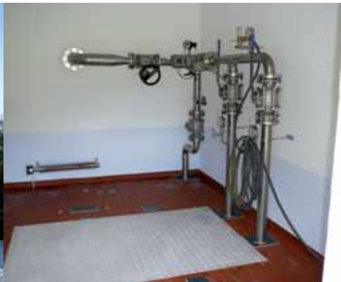
Sanierung Pumpstation Piger 2013
