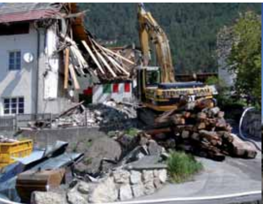
Abriss alte Schule / Gemeindeamt 2008
