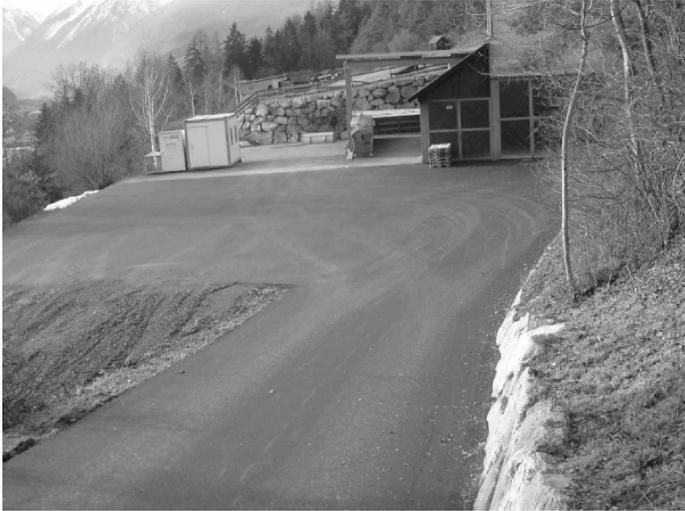
Der Vorplatz des Recyclinghofes wurde asphaltiert, sodass die Anlieferung und der Betrieb der Anlage problemloser und vor allem „staubfreier“ vonstatten gehen wird.
