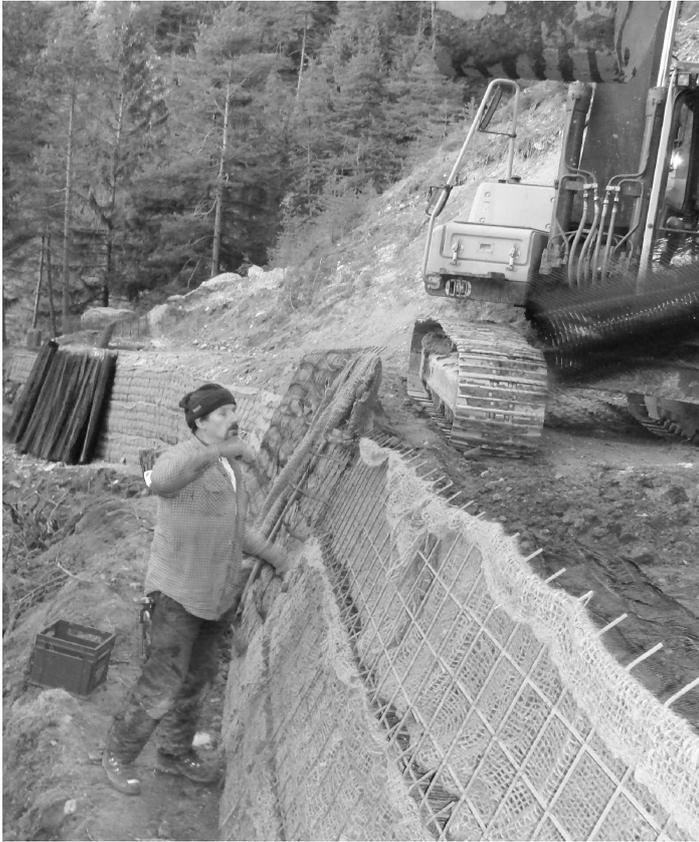
Herstellung einer Böschung mit Geogittern.
